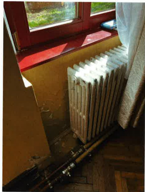
Igrasie la exteriorul si interiorul cladirii
