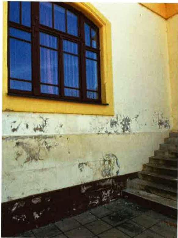
Igrasie la exteriorul si interiorul cladirii
