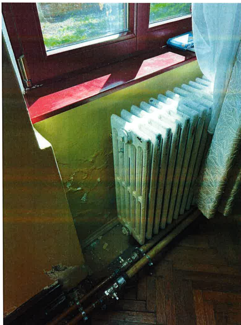
Igrasie la exteriorul si interiorul cladirii
